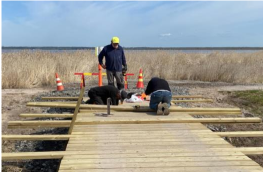
Sillan kannen rakentamista
